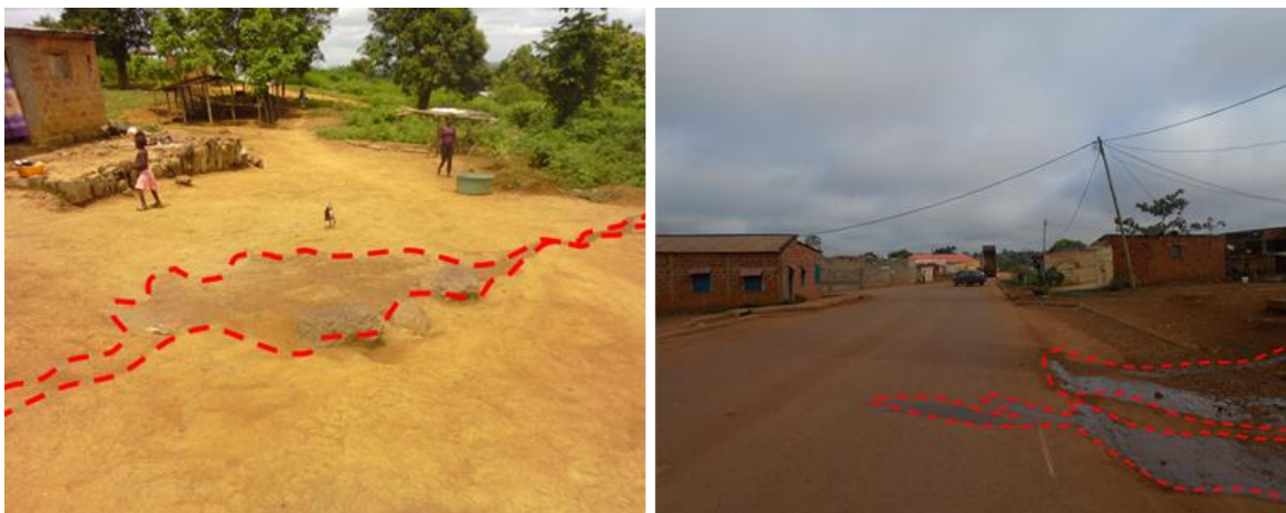
Figura 7 - Registo fotográfico de esgoto a escorrer a céu aberto, assinalado a tracejado vermelho.
